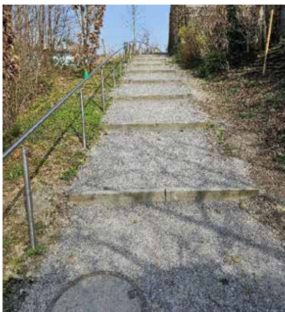
Der sanierte Gehweg zwischen der Rain- und Sennhüttenstrasse.
