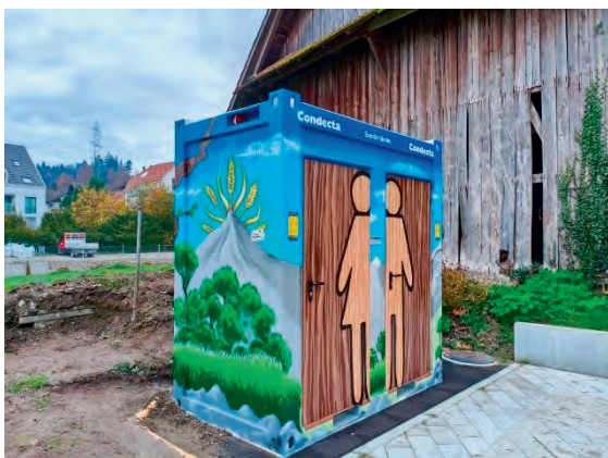
Das neue WC-Häuschen.
