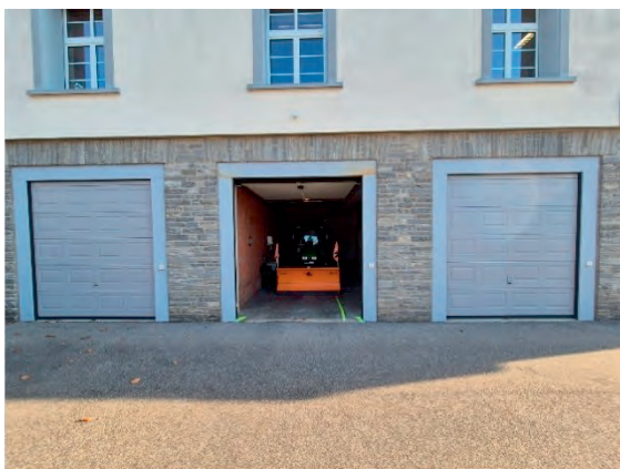
Auf Höhe der mittleren Garage wird der neue Lift eingebaut, rechts davon das neue Archiv.
