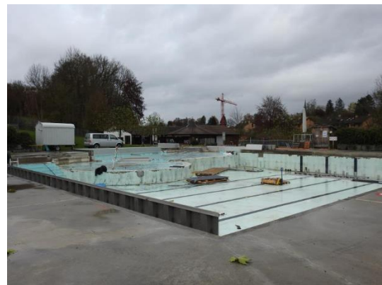
Fertigstellung Montage der ersten zwei Tran-chen Edelstahl-Beckenwände Mitte November
