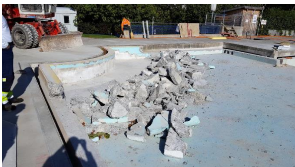
Rückbau Treppe Oktober
