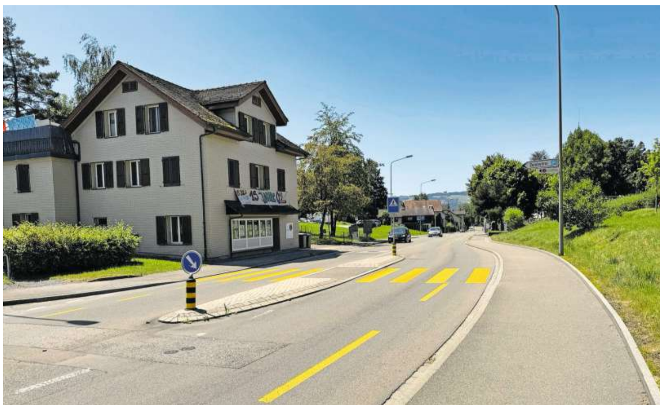
Die Sanierung der Dorfstrasse in Obfelden verzögert sich weiter. (Bild Dominik Stierli)
