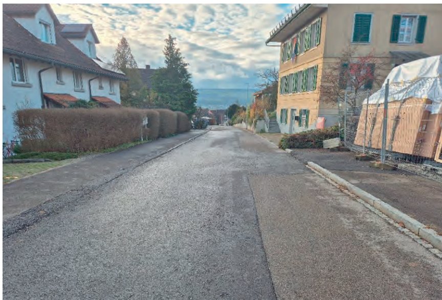
Um den Sanierungsbedarf besser zu koordinieren und zugleich den Nutzungsansprüchen an die Gemeindestrassen gerecht zu werden, erarbeitet die Gemeinde aktuell eine Strategie. Im Bild ein Abschnitt der Alten Schulhausstrasse.
