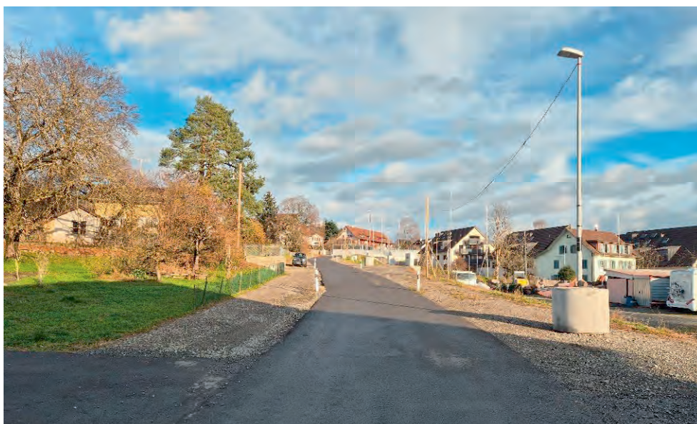
Um die Sicherheit zu gewährleisten, wurde die Bickwilerstrasse bis zur Umsetzung der Bauarbeiten mit einer provisorischen Beleuchtung ausgestattet.
