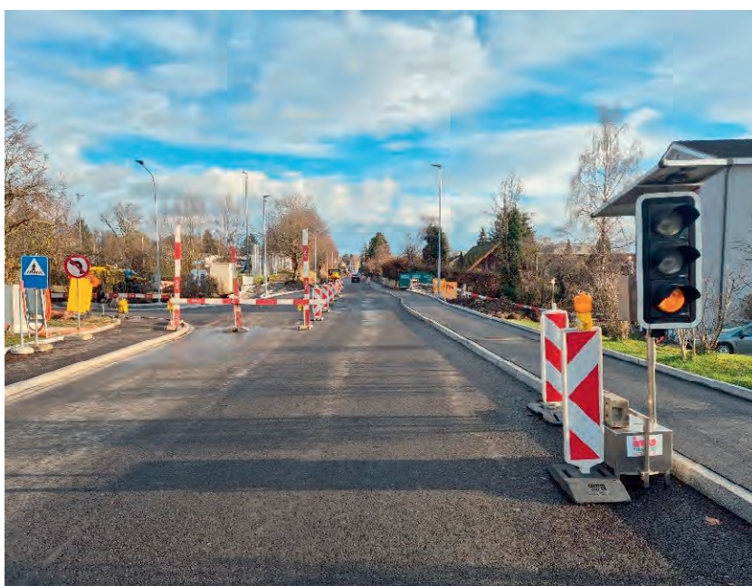
Bis Ende Jahr sollten die Bauarbeiten an der Ottenbacherstrasse abgeschlossen sein. Im Frühjahr 2025 erfolgt dann der Einbau des Deckbelags.
