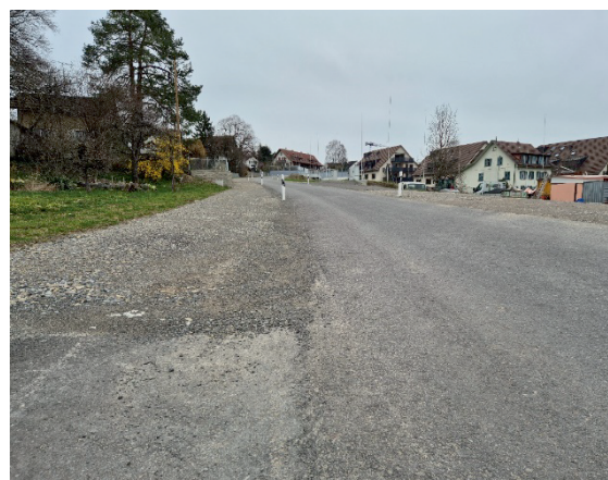
Die aktuelle Bickwilerstrasse im provisorischen Zustand.
