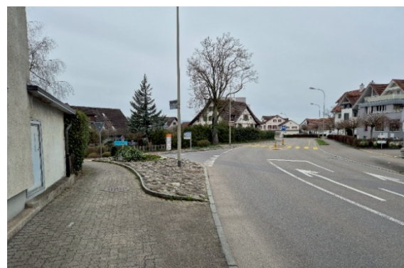
Die aktuelle Zu- und Wegfahrt in die Bächlerstrasse.
