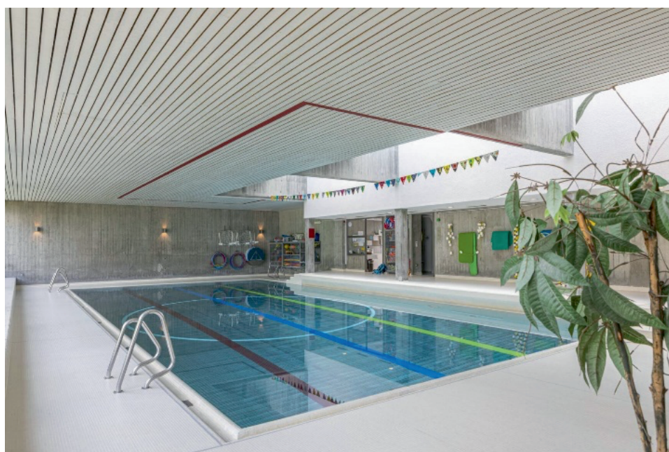
Das Hallenbad Schlossächer in seinem Zustand vor der Sanierung.
