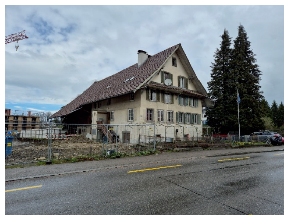
...und auch in der linken Gebäudehälfte im Gebäude an der Kreuzstrasse untergebracht.
