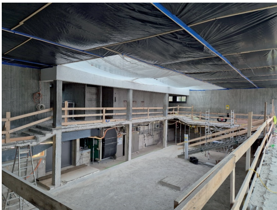
Blick in das Becken, die Seitenwände des alten Beckens sind komplett abgetragen.
