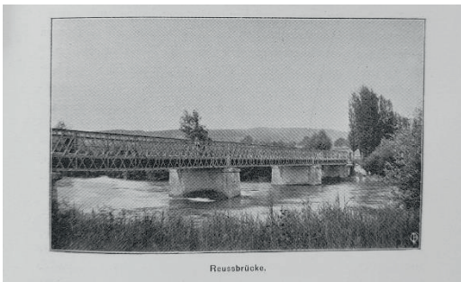
Zweite Reussbrücke von Obfelden nach Rickenbach. Erstellt 1875/76, ersetzt 1971 durch die heutige Reussbrücke
