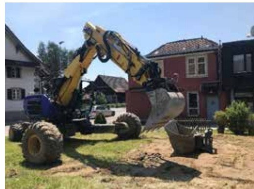
Auf dem Postareal wurden erste Sondierungen vorgenommen. Foto: Gemeinde Obfelden.
