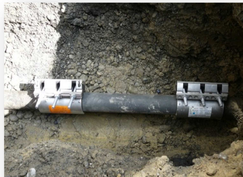
Das Frassloch an der Verteilleitung wurde herausgeschnitten und mit neuem Teilstück ersetzt.
