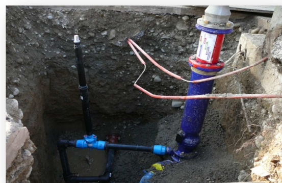
Neuer Hydrantenunterteil mit seitlichem Hausanschluss
