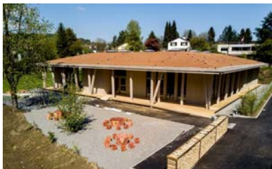
Mit Erdwärmepumpe geheizter Kindergarten Räsch (Quelle: Website Gemeinde Obfelden)
