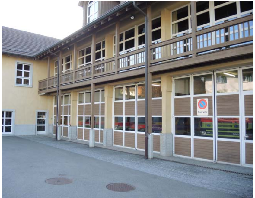
Feuerwehrstützpunkt im Mehrzweckgebäude Brunnmatt an der Schützenhausstrasse
