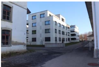
Bauliche Verdichtung im Areal Stehli
