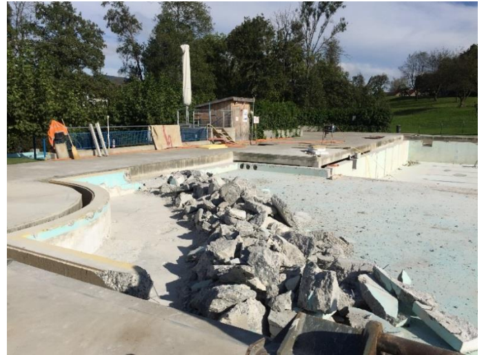
Betonschneide-Arbeiten an der Treppe des Nichtschwimmer-Beckens und Entfernung der Beckenköpfe
