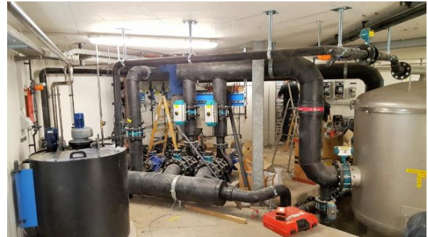
Technikraum Ende April: Die Arbeiten laufen auf Hochtouren. Die Badewassertechniker der Firma Bafilco, Elektriker der Blum Elco und Sanitärinstallateure der Ritschard Haustechnik AG sind vor Ort.
