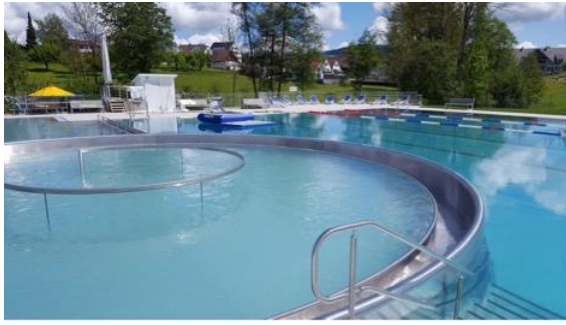
Neuer Strömungskanal mit Schaukelbucht
