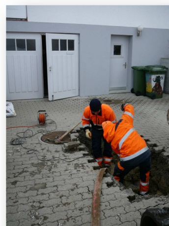
Leitungsbruch Hausanschluss
